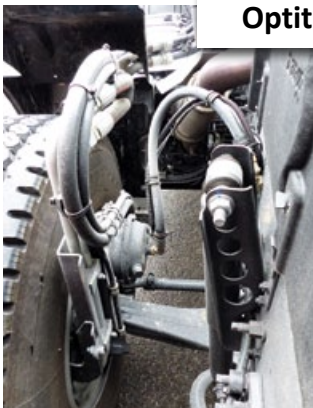
Bei Optitrack werden die Hochdruck-Ölleitungen aus Metall in einer Schiene von oben nach unten geführt
