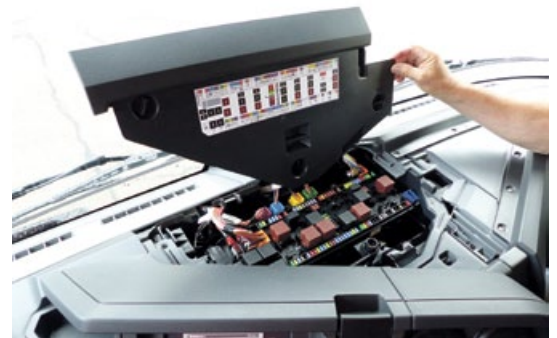
Die einfach zugängliche Zentral-Elektrik erleichtert den Sicherungs- und Relais-Check
